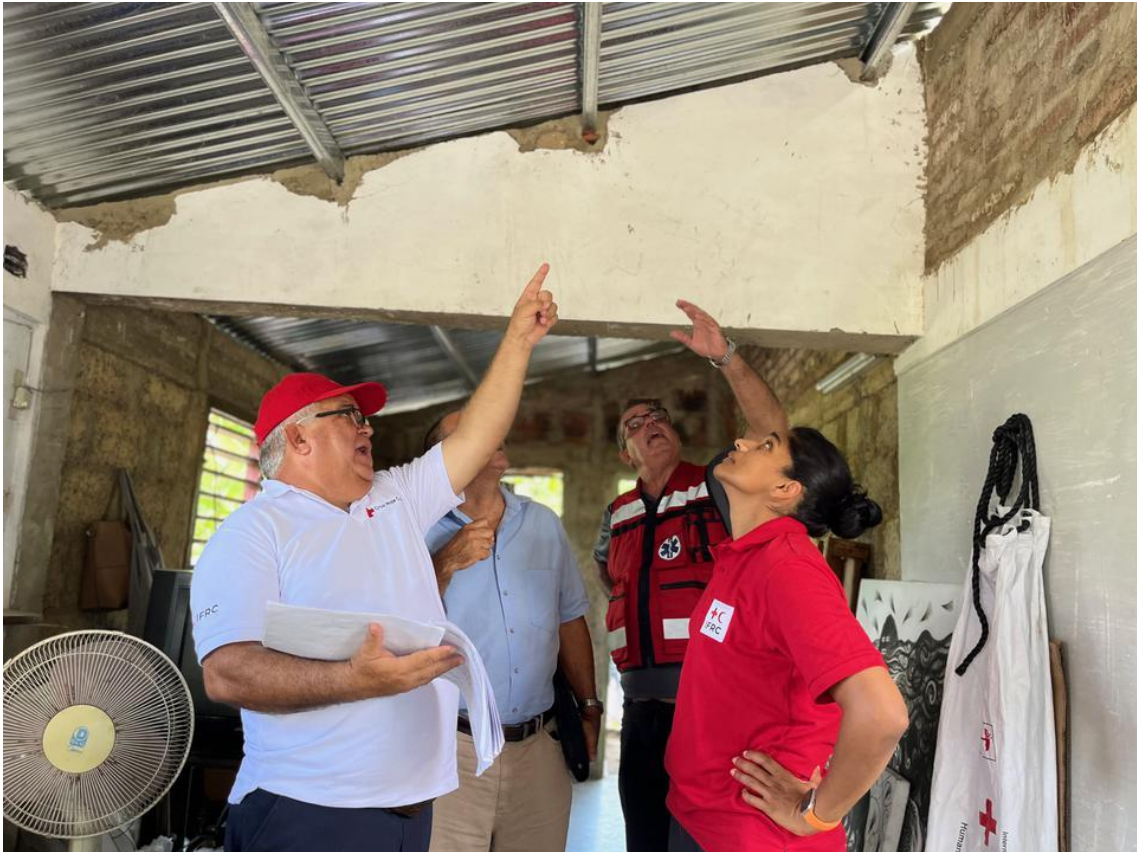
Foto: Altos representantes de la CRC, el Gobierno de Cuba y la IFRC (de izquierda a derecha) realizan una visita conjunta de monitoreo para inspeccionar la calidad de los techos como parte de los esfuerzos de aseguramiento de la calidad, julio de 2023 (Pinar del Río). Fuente: Cruz Roja Cubana/IFRC.
